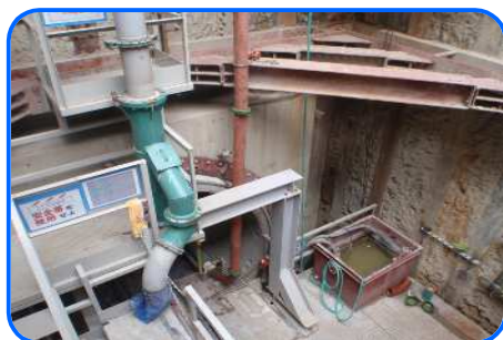
■ コンクリート落下装置
