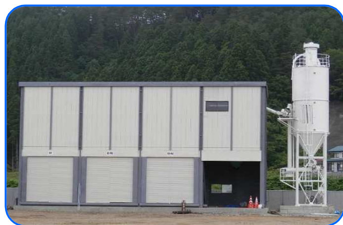
■バッチャープラント
