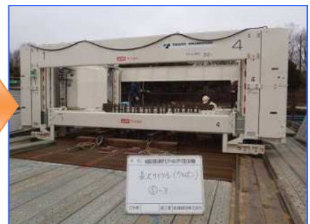
鉄筋かご建込み後
