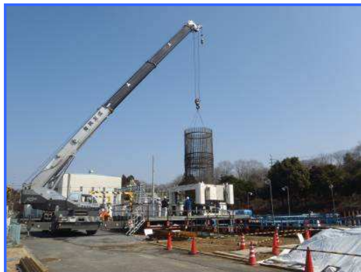
鉄筋かごの分割施工に適応可能です。
