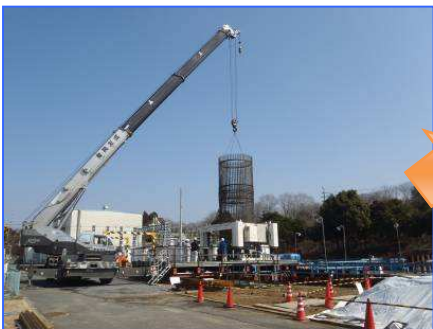
鉄筋かごの上空からの供給
